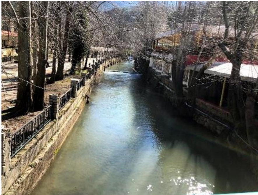
Road 5-(Bassaten Al Ossi – Beit Chelala) (34°13'22.4"N 35°50'24.4"E) A. Maalouf, A. Chehab, M. (Jan, 2019)
