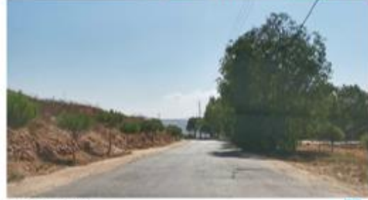
Road 6b - Sta 7+600
