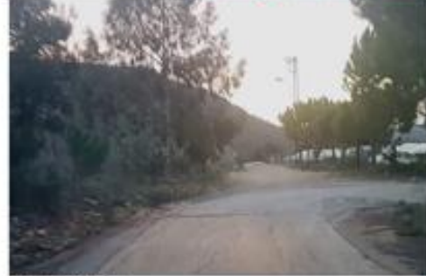
Road 1a - Sta 2+825
