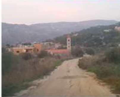
Road 1a - Sta 3+645
