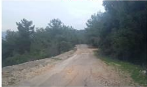
Road 1a - Sta 0+610
