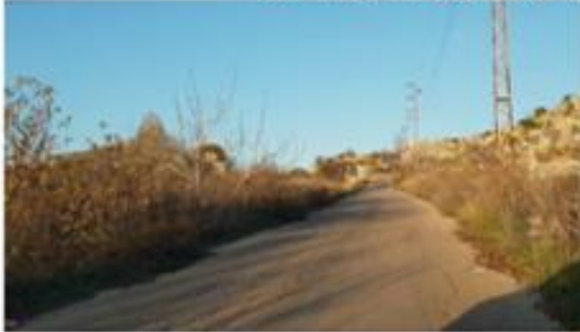
Road 1c - Sta 1+455
