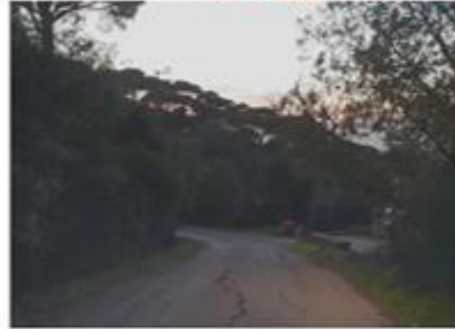
Road 1a - Sta 2+270
