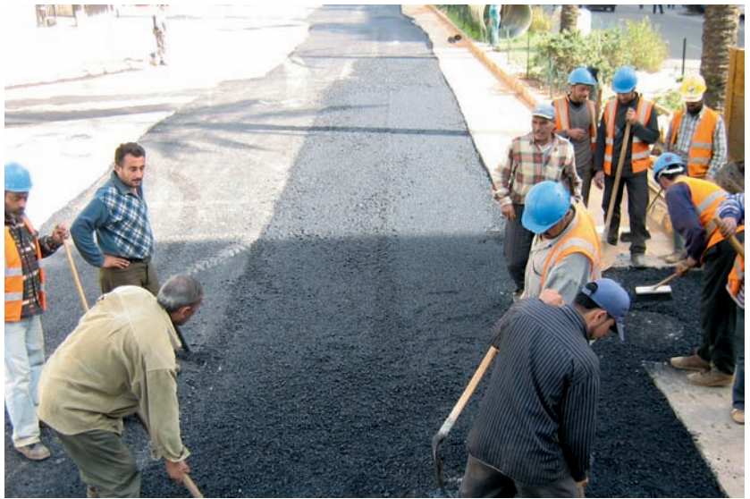
مشاريع تأهيل البنى التحتية لمدينة بيروت (جادة صائب سلام - كورنيش المزرعة)
