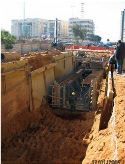
مشاريع تأهيل البنى التحتية لمدينة بيروت (شارع فنزويلا)
