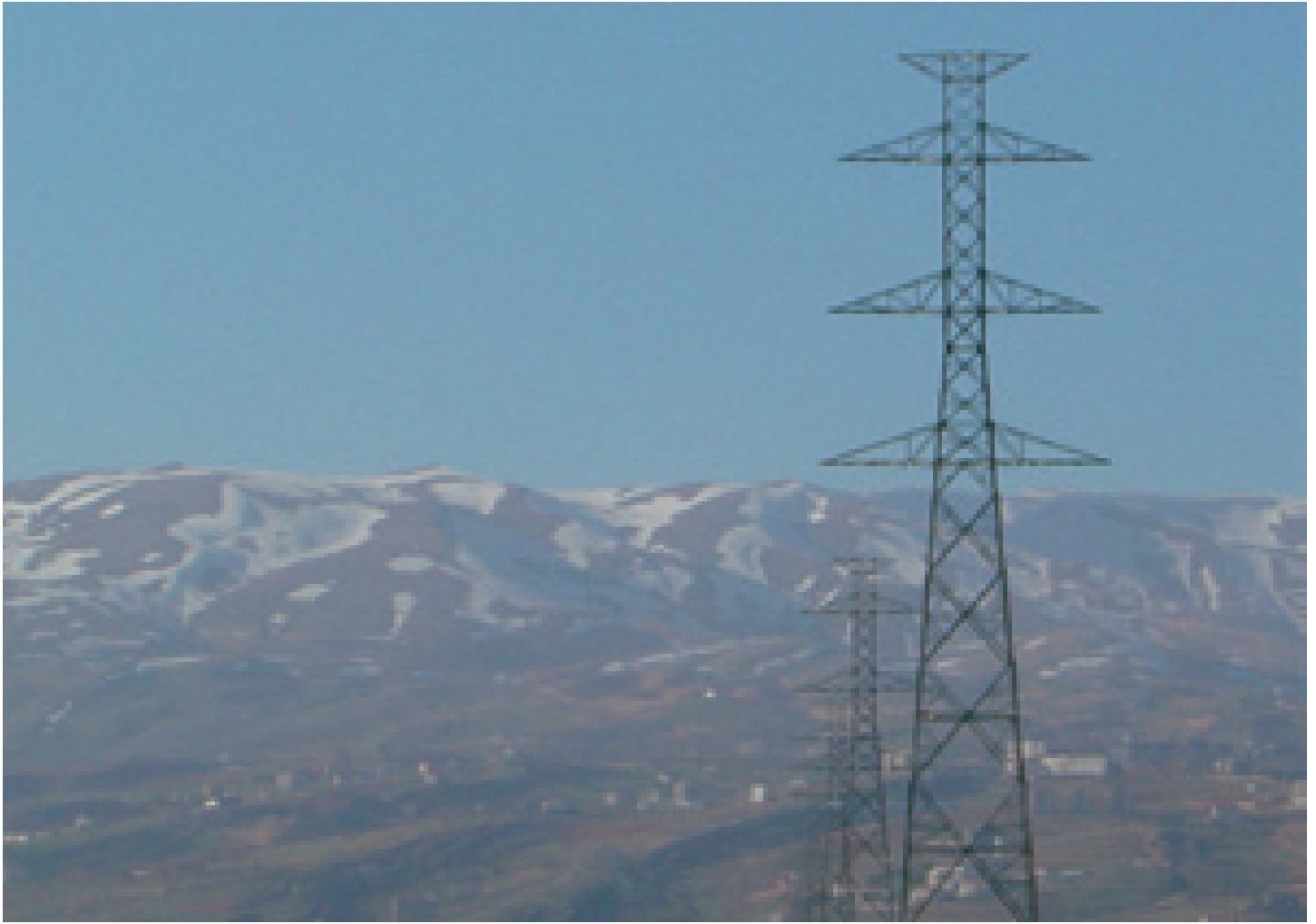
مد خطوط الكهرباء ٤٠٠ كيلو فولت في منطقة كسارة - الحدود السورية ضمن مشروع الربط السباعي
