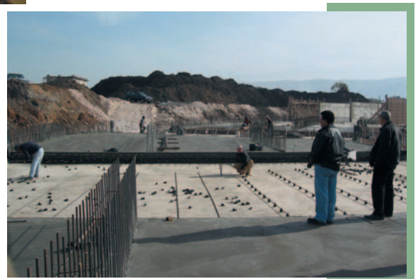
Travaux en cours sur l'autoroute arabe : Taanayel - Masnaa
