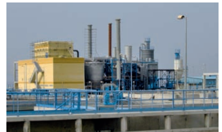
La station d'épuration de Tripoli
