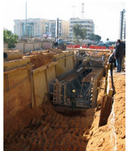
Projets de réhabilitation de l'infrastructure dans la ville de Beyrouth (Rue Venezia)
