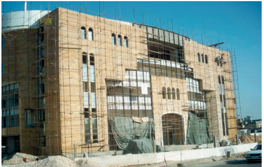
Immeuble abritant le Centre de Contrôle (en construction)
