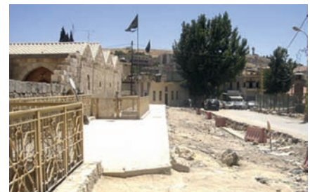
La place de la grande Mosquée avant réhabilitation
