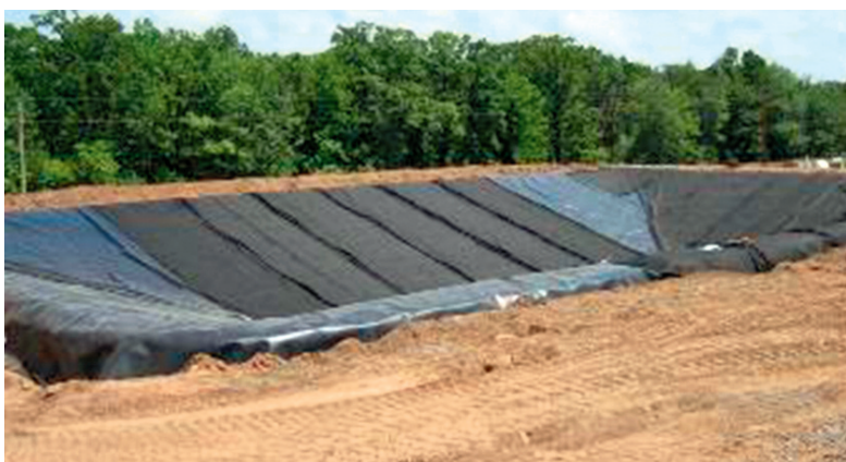
Rehabilitation - Zahle Landfil
