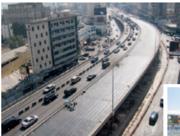
Projet du Transport Urbain: Pont de Dora.
