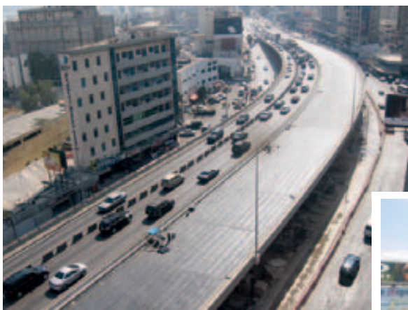
Projet du Transport Urbain: Pont de Dora.
