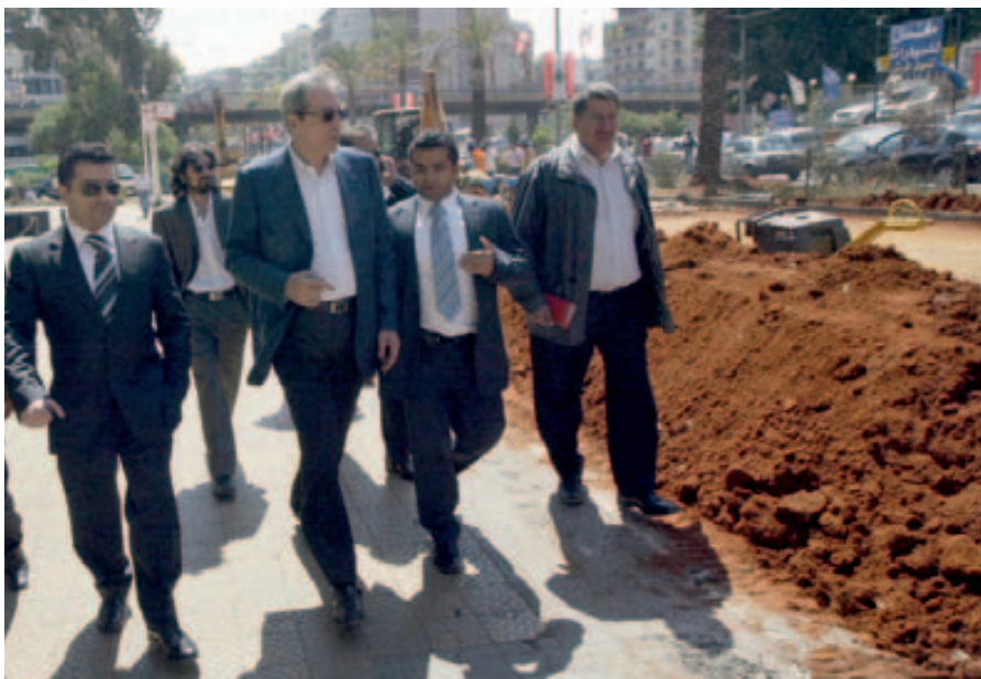
Le Président Jisr lors de l'inspection des travaux à Corniche Mazraa.
